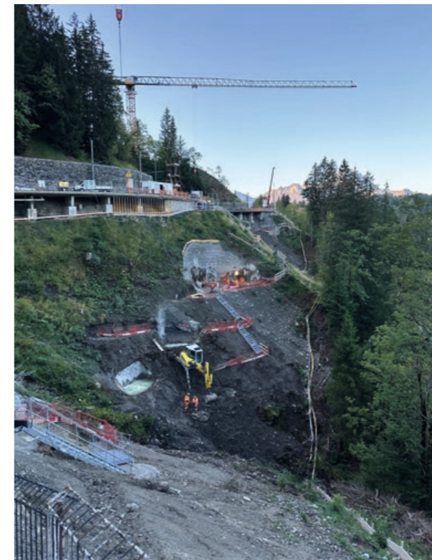
Vue des travaux vers la Gare de Barboleuse, construction des fondations du futur pont
