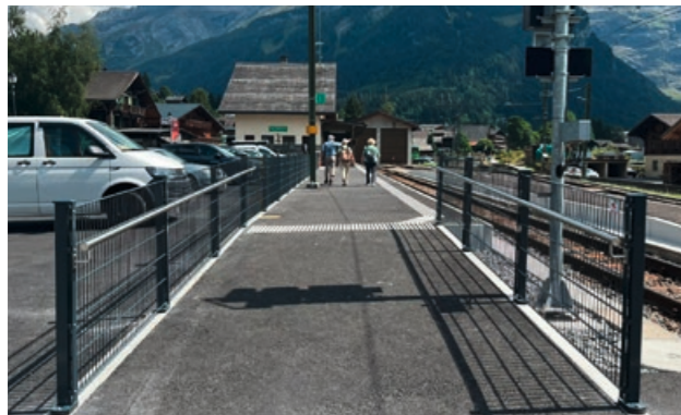
Marquage podotactile et barrières de sécurisation de la limite quai/parking
