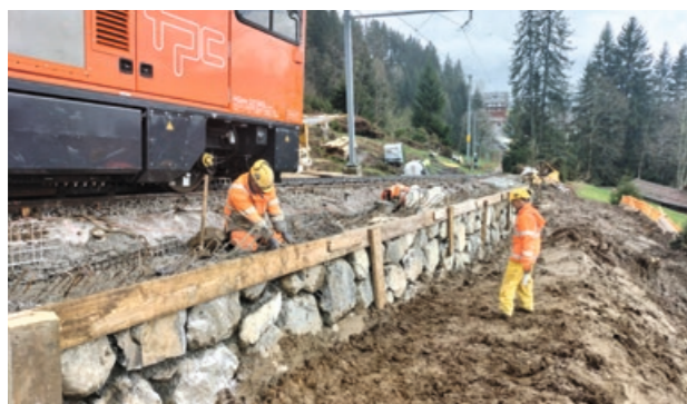
Mur de soutènement en enrochement bétonné
