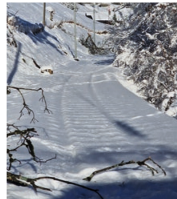
Ligne de l'AOMC entre Troistorrents et Champéry
