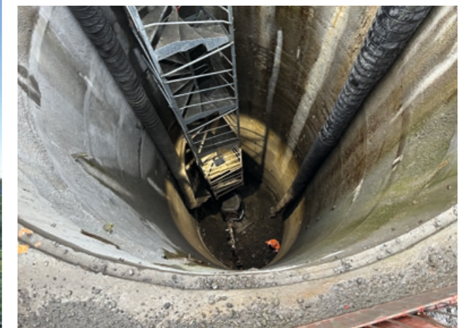
Puit de fondation de pile de 18m de profondeur
