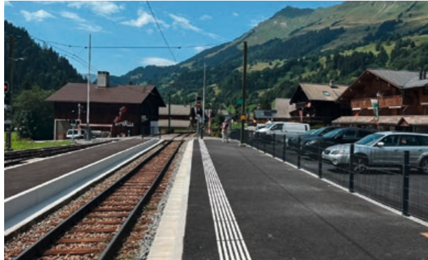
Rampe d'accès LHand au quai principal de la gare des Diablerets
