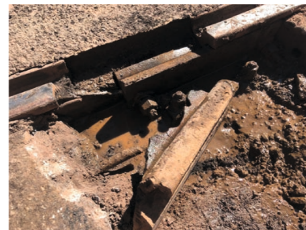
Rail cassé au niveau du joint du pont des Planches
