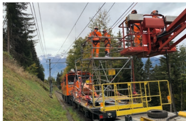
En plus de l'utilisation de l'unique nacelle de travail disponible, il a été nécessaire de construire un échafaudage sur un wagon pour assurer la sécurité des monteurs de ligne de contact.
