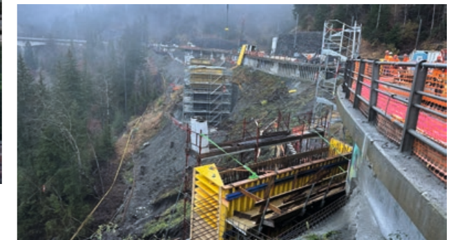
Vue des travaux vers Villars, construction des piles et culées
