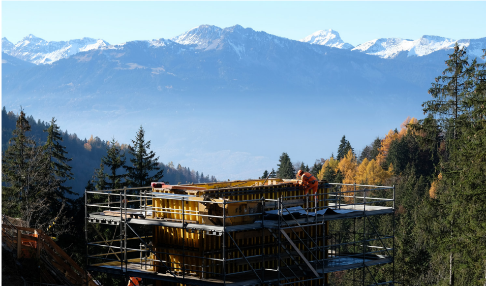
© Eric Frigière / novembre 2023 - construction de l'un des piliers du pont.
