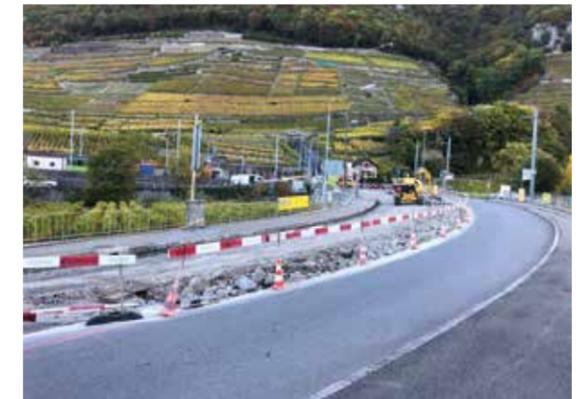
^ Démolition de la dalle en béton sous les anciennes voies de l'Aigle-Leysin sur le pont de la Grande-Eau
